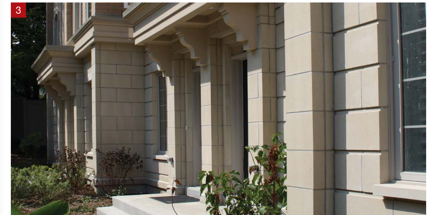
1. Les Éléments d'Arches et Piliers sur Mesure, Pierre Arrondie | 2. Pierre Arrondie et Détails sur Mesure | 3. Chanfreins et Allèges
