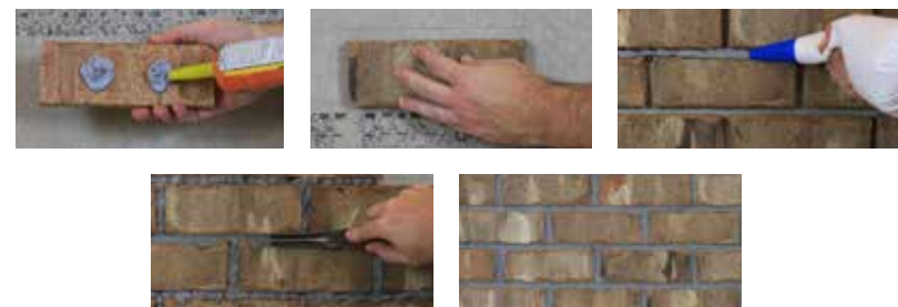
Installation intérieure avec adhésif
